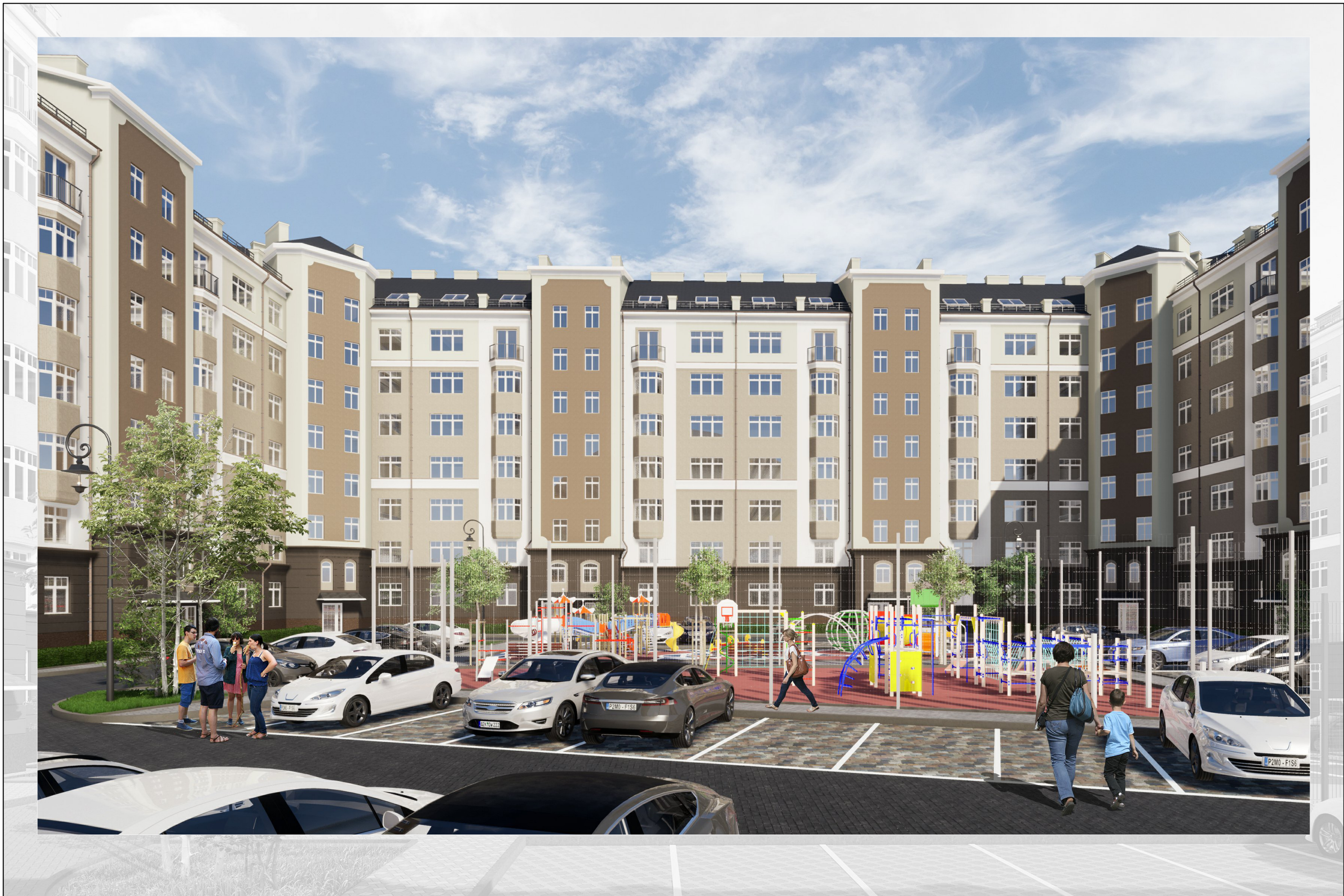
Многоквартирные жилые дома по ул. А. Невского, 192 в Ленинградском районе г. Калининграда Дом № 2 по ПЗУ ООО "АСБ"
