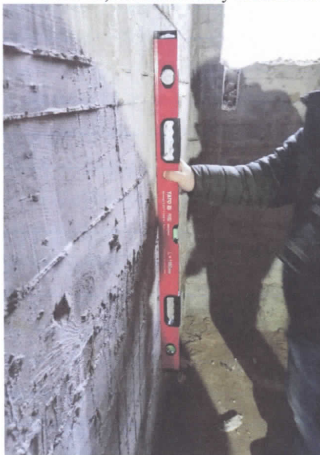
Фото 25,26.Места выпучивания стены до 25 мм
