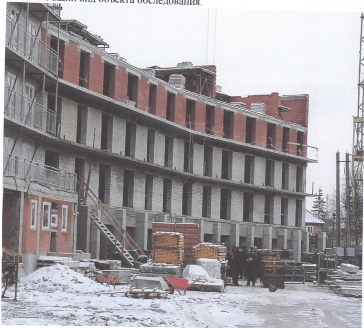
Фото 1. Общий вид объекта обследования.
