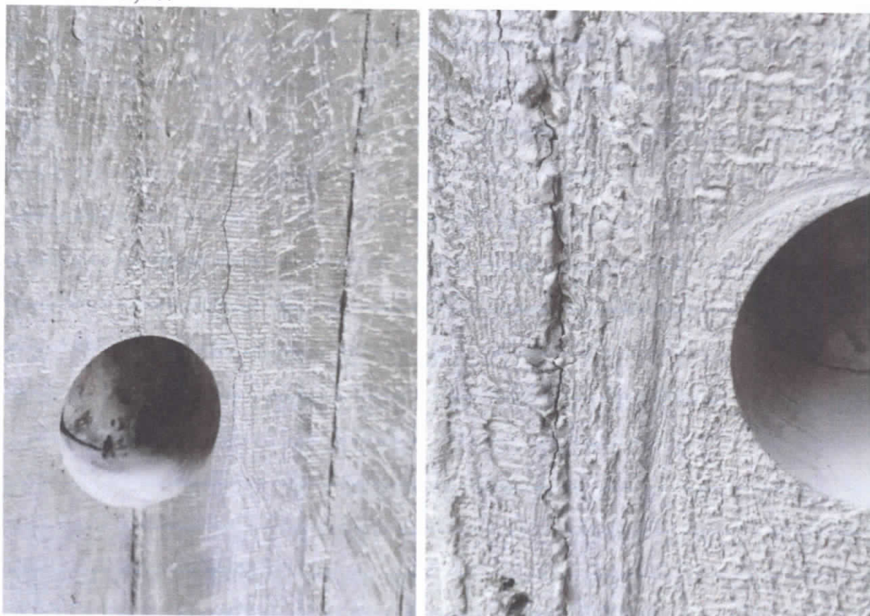
Трещины вертикального развития в местах отбора проб бетона. Фото 9,10.
