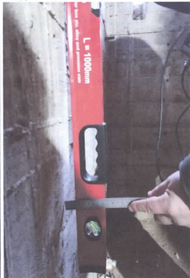
Фото 25,26.Места выпучивания стены до 25 мм
